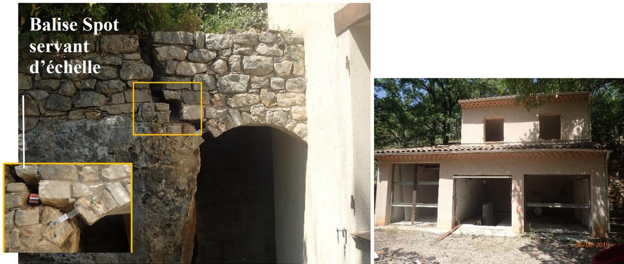
*Fissuration ouverte dans le mur en prolongement ouest de la maison endommagée et maison abandonné restée intacte, Peyrui*
